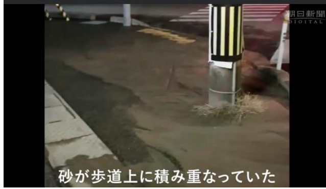
Şekil 8 Sivilaşma sonrası meydana gelen kum fışkırmaları ve yer altı suyu çıkışları
