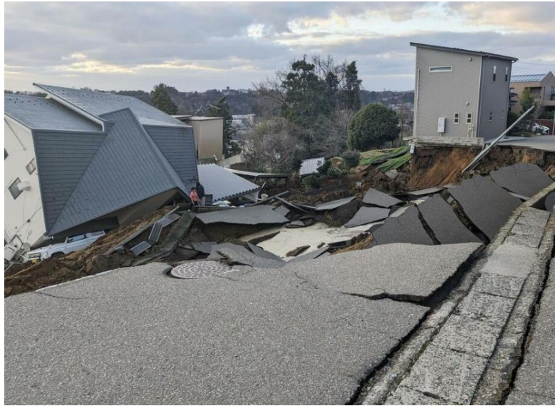
Şekil 6 Hasar gören yol örnekleri
