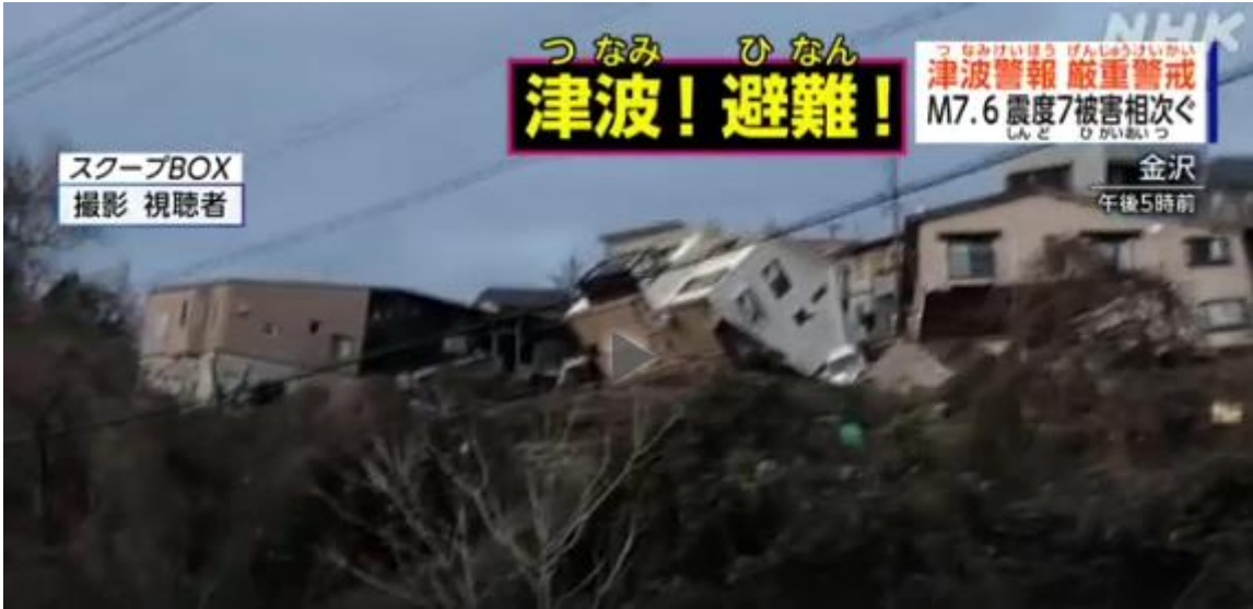
Şekil 9 Sıvılaşma nedenli tipik yapı hasarları
