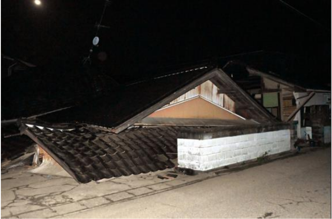
Şekil 5 Hasar gören ahşap ve yığma yapı örnekleri
