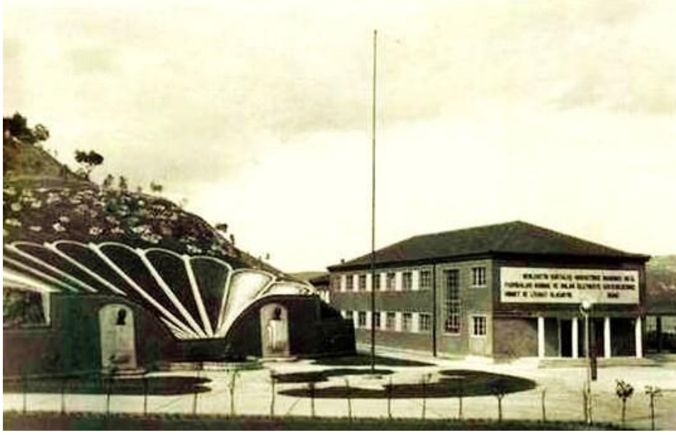
Sunğipek Fabrikası İdare Binası (1950). Fotoğraf
