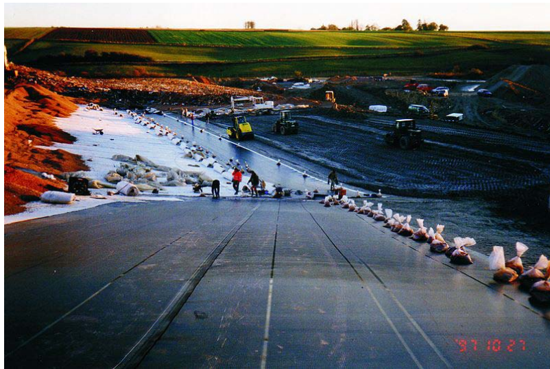
Şekil 6.14. Depolama alanlarında geomembran döşeme süreci
