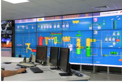
Şekil 30. Yakma tesisi kontrol odası (İZAYDAŞ örneđi)
