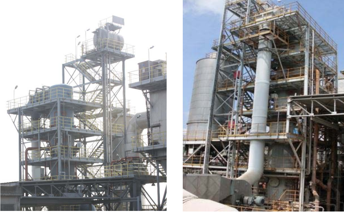
Şekil 25. İZAYDAŞ yakma tesisi Venturi yıkayıcısı ve kireç püskürtmeli yıkayıcısının genel görünümü
