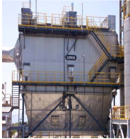
Şekil 21. Elektrostatik çöktürücü
