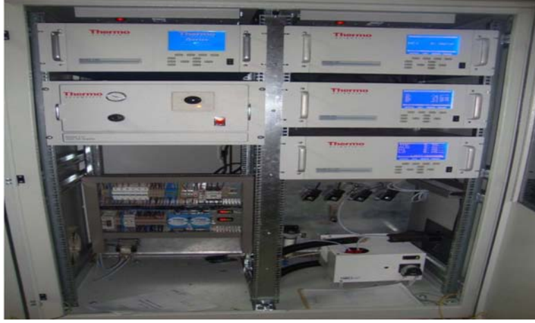
Şekil 32. İZAYDAŞ yakma tesisi baca gazı ölçüm cihazı
