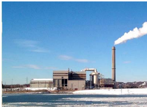
Şekil 17. Bir yakma tesisi
