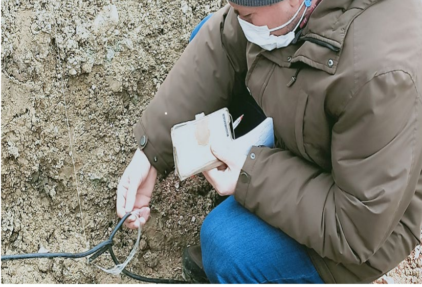
Resim-Alt yapı alıřmaları sırasında kopan F/O kablo onarımı
