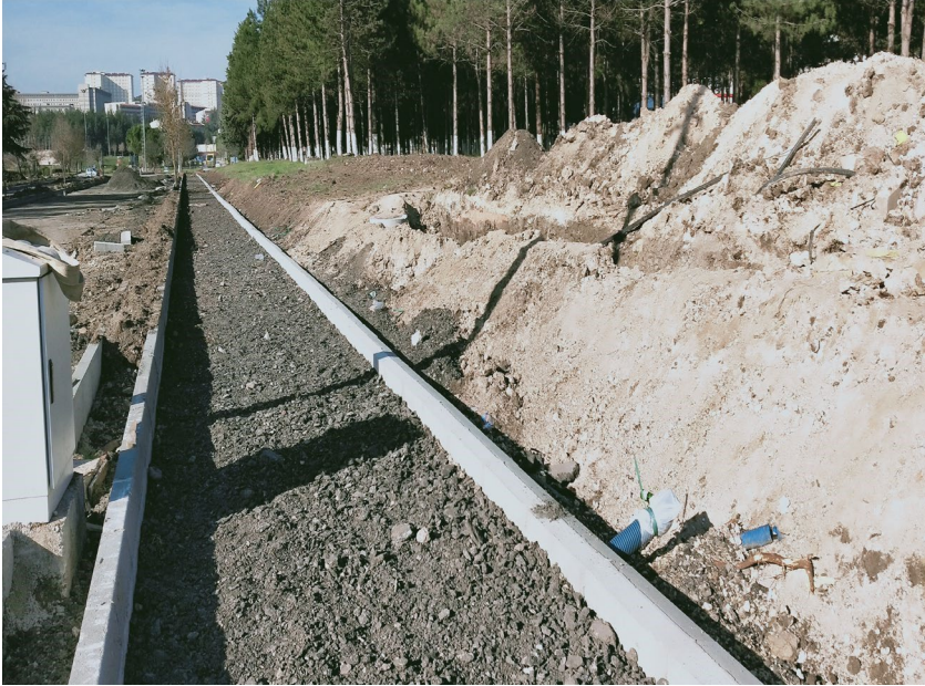
Resim-Alt yapı çalışmaları sırasında kopan F/O kablo onarımı
