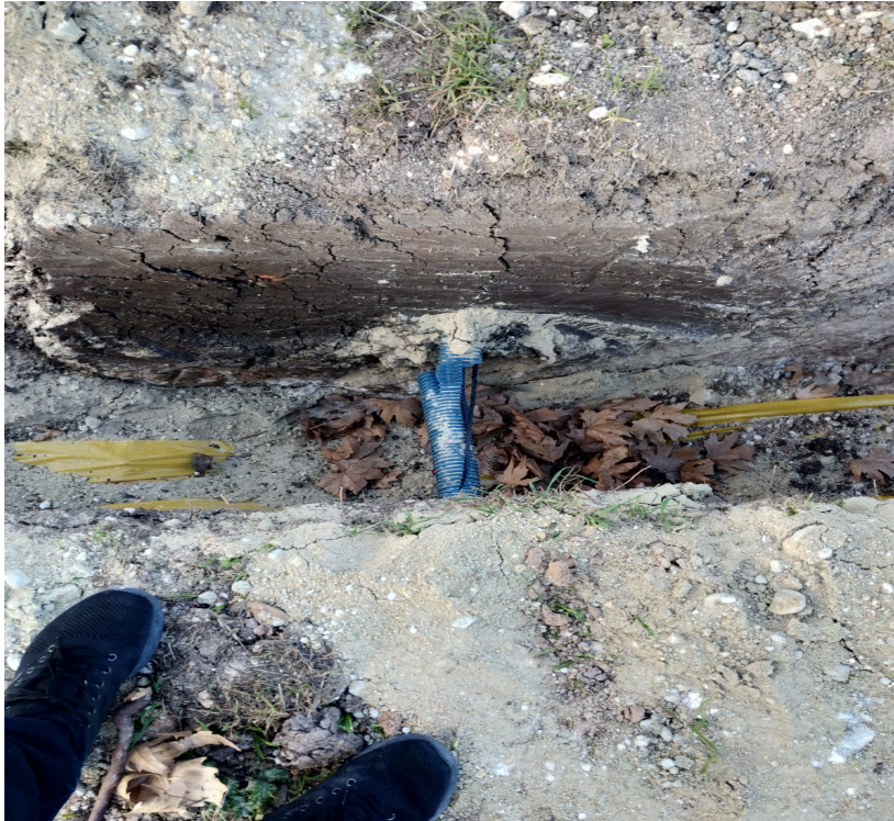
Resim-Alt yapı çalışmaları sırasında kopan F/O kablo
