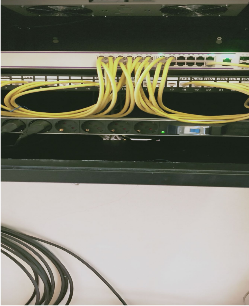
Resim-Online eğitim derslikler için internet erişim için kabin ve switch konu. (Çalışır durumda)
