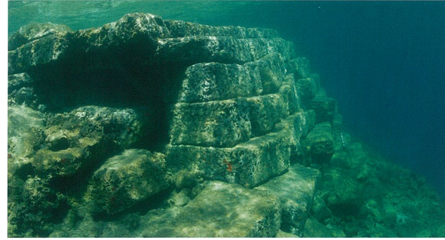
Fig. 2: Antik liman girişinde Kocadağ'ın kıyısında yer alan mendirek kalıntısı. Depremler veya deniz suyunun yükselmesi nedeniyle günümüzde 50 cm kadar su altında kalmıştır.
