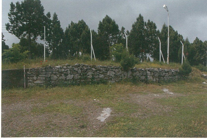
Resim 100 - Asartepe mevkiinde horasan harçlı duvar.
