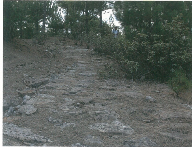
Resim 126 - Sakarca mevkiinde yol kalıntısı
