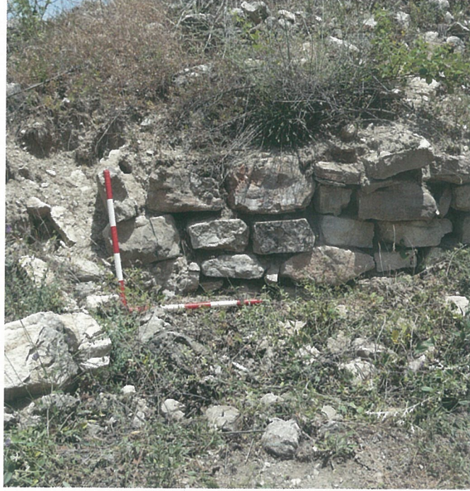
Resim 39- Davutlar Köyü Kaleler Mevkiinde duvar kalıntıları
