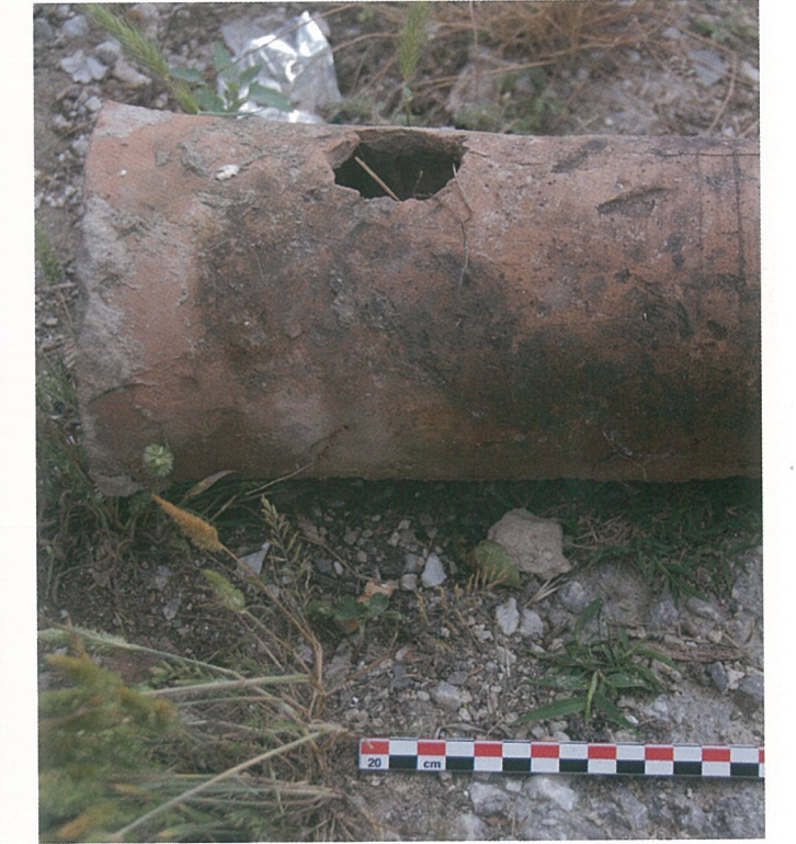
Resim 93- Ilıcaksu Köyü termal havuzlarına su taşıyan kapalı su kanalına ait künklerden bir örnek.
