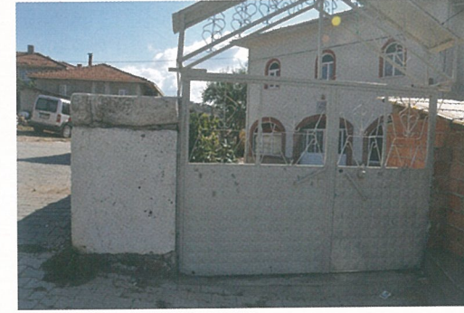
Resim 119 - Karaağz Köyü cami bahçesinin duvarında kullanılan devşirme taşlar.
