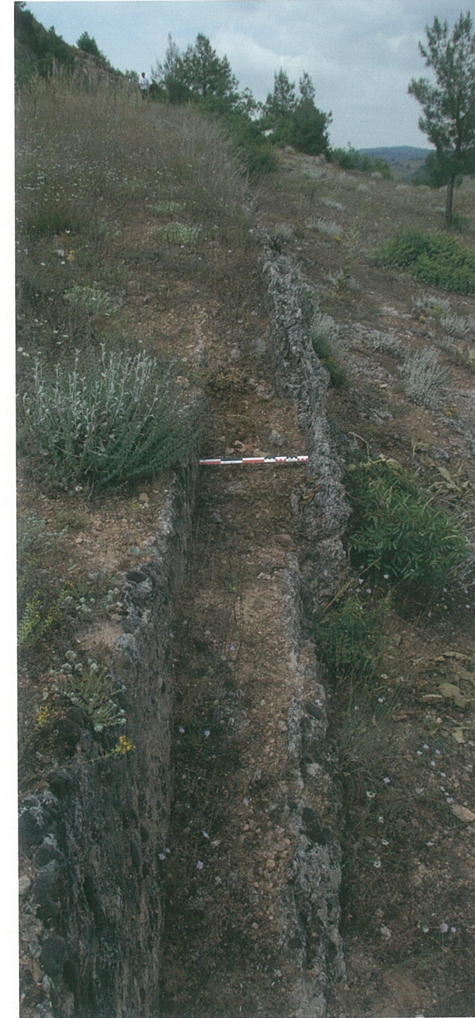
Resim 91 - Ilıcaksu Köyü termal havuzlarına su taşıyan açık su kanalı.
