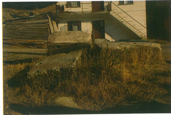
Resim 3- Sofular Mahallesi'nde alt yapı çalışmalarında bulunan mimari bloklar.
