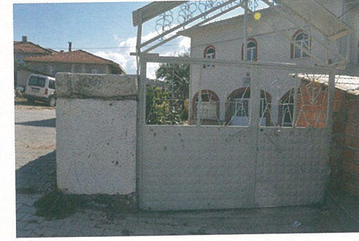
Resim 119 - Karaağız Köyü cami bahçesinin duvarında kullanılan devşirme taşlar.
