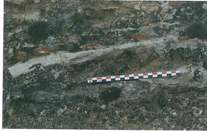
Resim 94 - Ilicaksu Köyü termal havuzlarına su taşıyan kapalı su kanalına ait künklerden kireç tabaka nedeniyle kullanılmaz hale gelen bir örnek.
