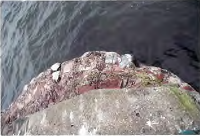
Resim 24. Seyir Terası. Temelde antike döneme ait yapı kalıntısı
