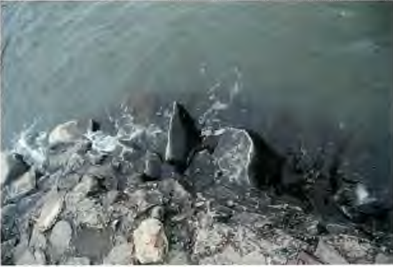
Resim 12. Yarım daire şeklinde sona eren duvarın üstten görünüşü.
