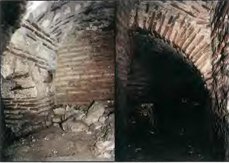
Resim 5. Kemalpaşa Mahallesi Arabacı Sokak Altyapısında tonoz örgüleri.
