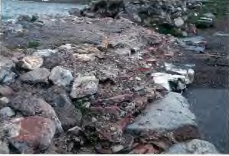
Resim 13. Platformdan detay. Alttaki dikdörtgen kesilmiş taş bloklardan temel, bunun üzerinde kare şeklindeki tuğla sırası ve en üstte de horasan harçlı moloz taşlardan blokaj.
