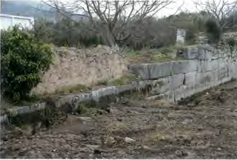
Resim 4. Duvarın güney yanına giydirilen taş kaplama.
