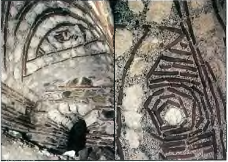
Resim 6. Kemalpaşa Mahallesi Arabacı Sokak Altyapısında tonoz örgüleri.
