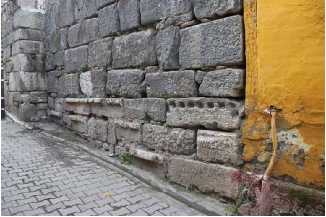
Res. 15: Ge Dönem surlarında yer alan devşirme bloklar (Şahin 2016, 183 Res. 434)
