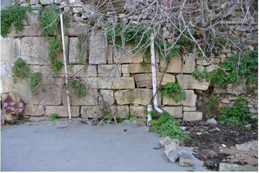
Res. 14: Ge Dönem surlarında yer alan devşirme bloklar (Şahin 2016, 183 Res. 433)
