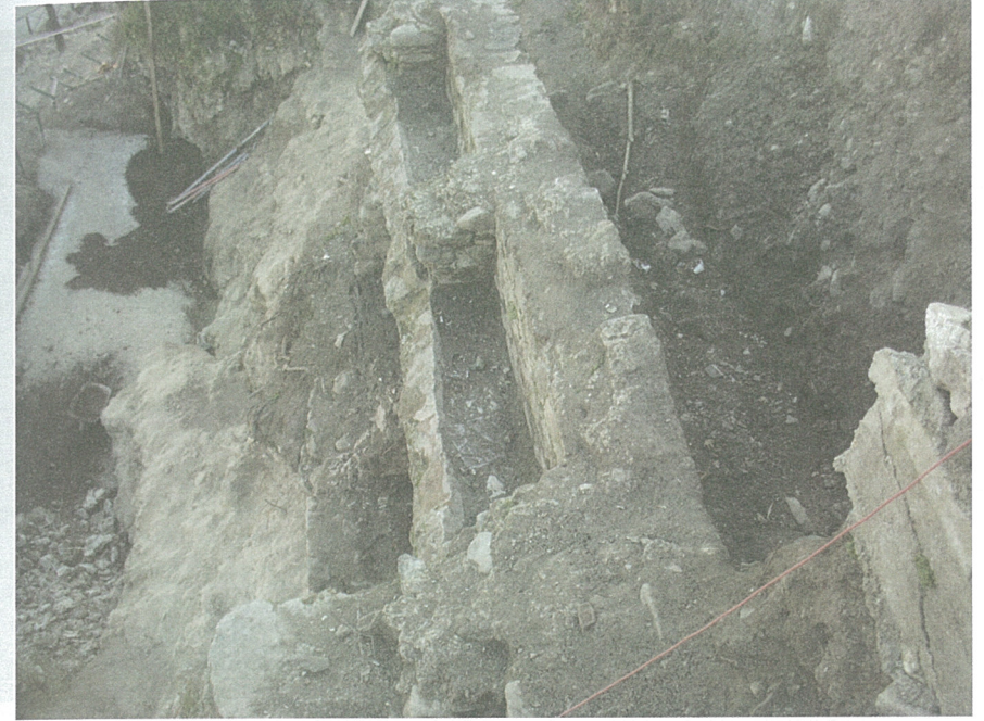
Resim 11. "B Kulesi"nde kazı çalışmaları. Üstten görünüş (Foto: İbrahim Yılmaz).
