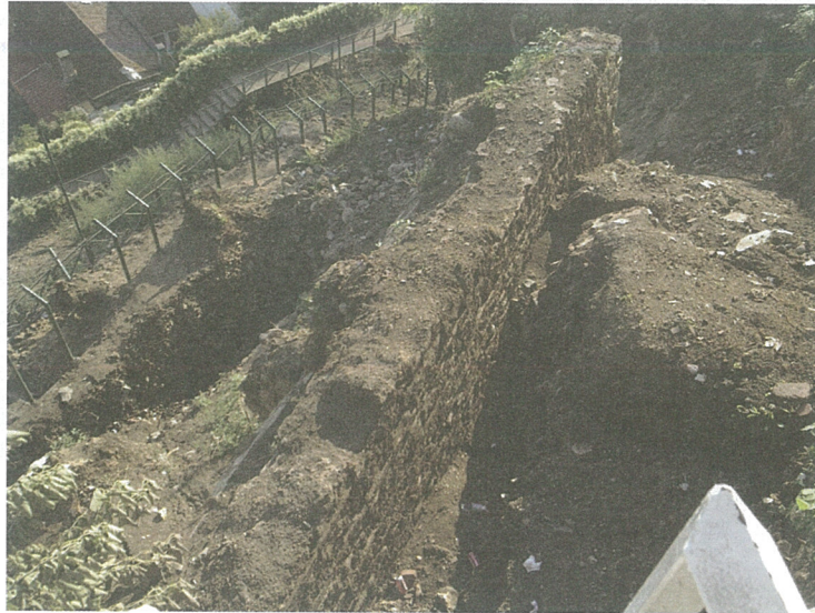
Resim 10. "B Kulesi"nde restorasyon öncesi temizlik çalışmaları (Foto: İbrahim Yılmaz).
