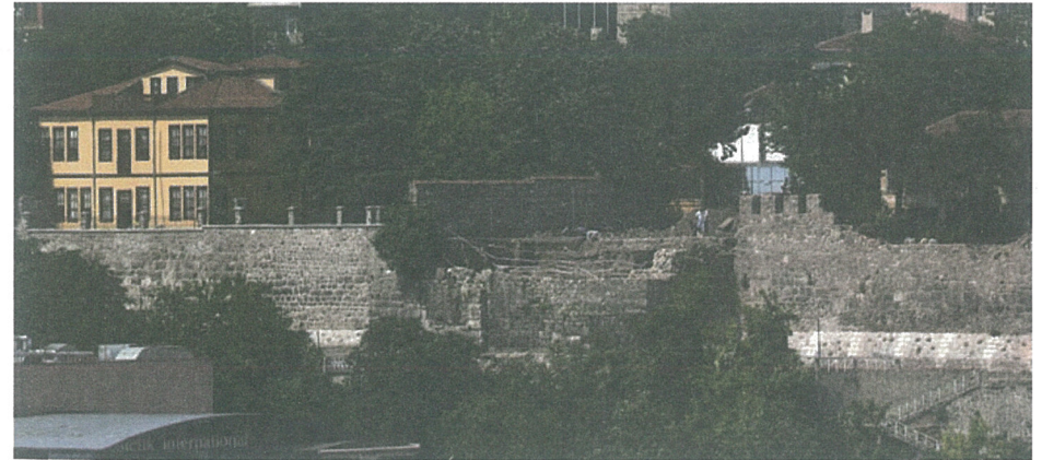
Resim 8. Eski müftülük yanında sur onarım çalışmaları (Foto: İbrahim Yılmaz).
