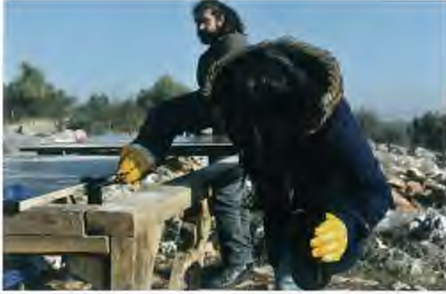
Şekil 8 : Kesilen yüzeylerin yalıtılması.
