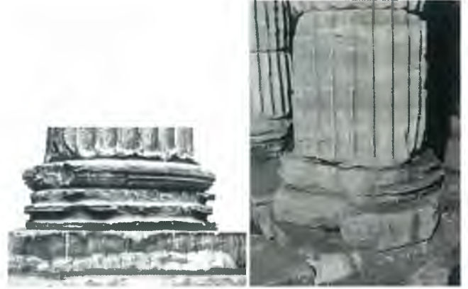
Şekil 20a : Sütun kaidesinin üst torus ile olması gereken doğru şekli (Berlin Pergamon Müzesi).
